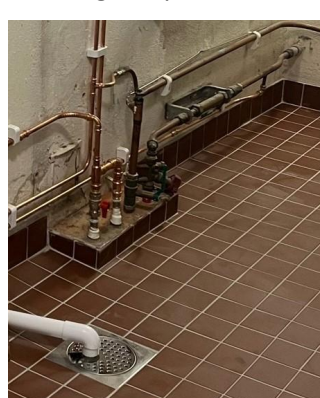
Kaklat golv i pannrummet
