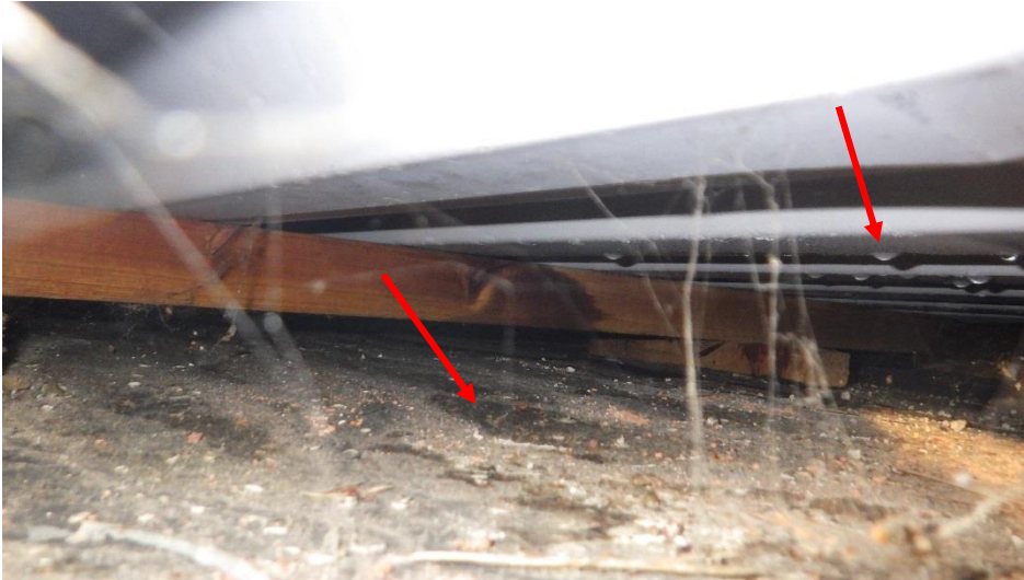
Foto 1. Kondens, vattendrop- par samt rinnande vat- ten på papp förekom- mer under takplåt, fo- ton tagna vid torr vä- derlek.
