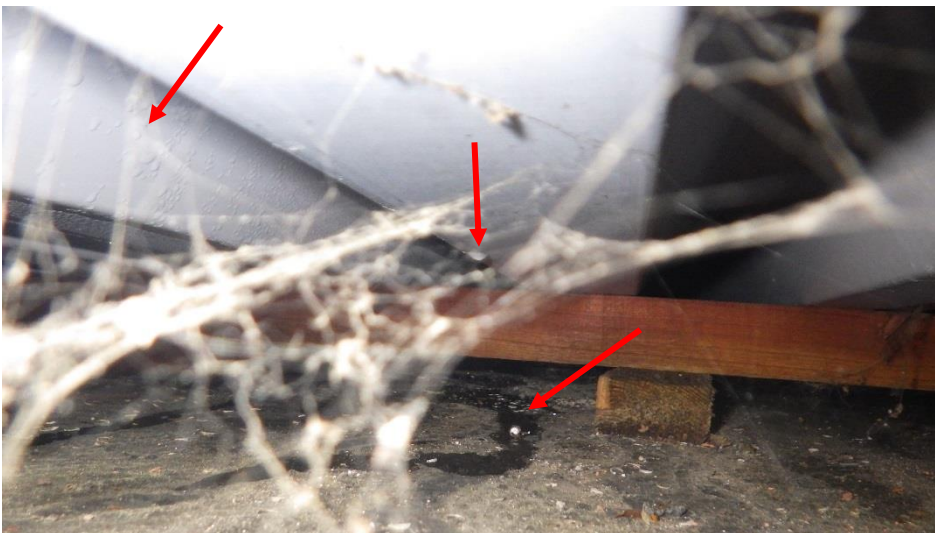
Foto 2. Kondens och rinnande vatten.
