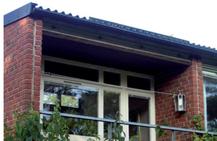
Övervåning mot baksida (Rrv 80)
