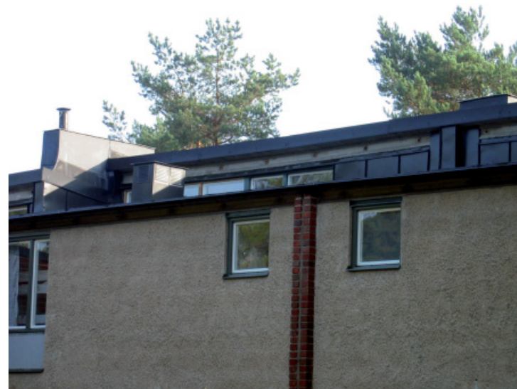
Övervåning mot entrésida (Rrv 90)
