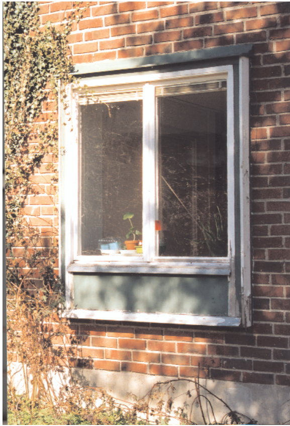
Bild 7. Detalj av burspråk på gavel. Hustyp B.
