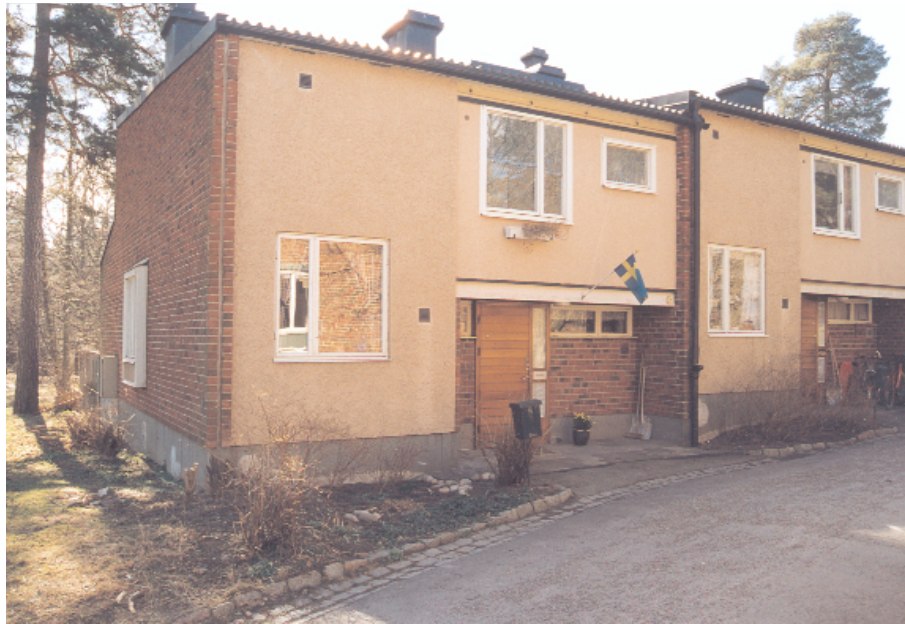
Bild 15. Huslänga 13 har genomgått en fasadrestaurering. Ursprungliga sisi- och eternitplattor i det utfackade partiet har bytts ut mot putsade fasadskivor. Även putsen är utbytt. Fönstren är inklädda med plåt.
