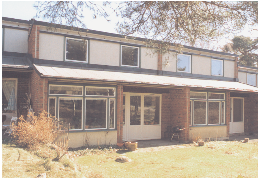
Bild 5. Hustyp B, huslänga 11, gårdsfasad. Fasadskivorna på det övre fasadpartiet är sekundära och har ersatt de ursprungliga sidiplattorna.
