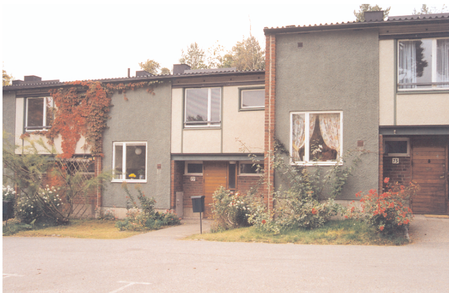
Bild.14. Huslänga 12 har genomgått en fasadrestaurering. Ursprungliga sidi- och eternitplattor i det utfackade partiet har bytts ut mot putsade fasadskivor. Även put-sen är utbytt.
