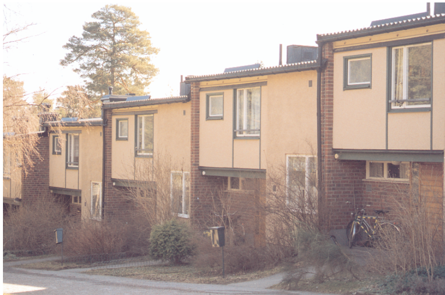
Bild.16. Huslänga 14 har genomgått en fasadrestaurering. Ursprungliga sisi- och eternitplattor i det utfackade partiet har bytts ut mot putsade fasadskivor. Även putsen är utbytt.
