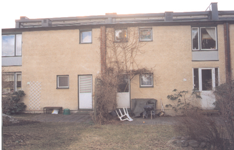
Bild 20. Altandörr har ersatt fönstret i bottenvåningen i lägenhet 3:2, Riksråds- vägen 66.
